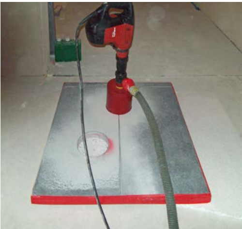
Millimeter genaues Ausschneiden der Putzöffnungen
