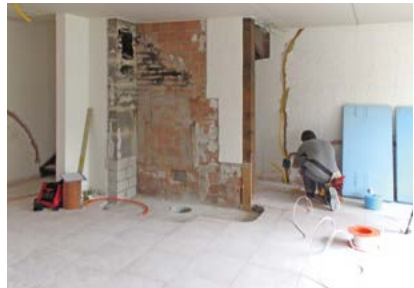
Situation nach Abbruch
