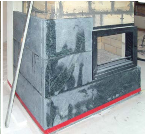
Aufbau Speckstein Einfassung
